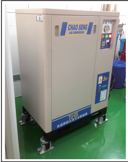
空壓機安裝YS-B彈簧式避振器
