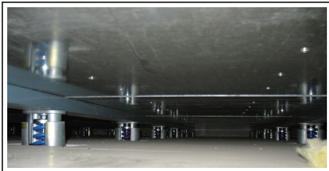
浮動地板安裝YS-B彈簧式避振器
