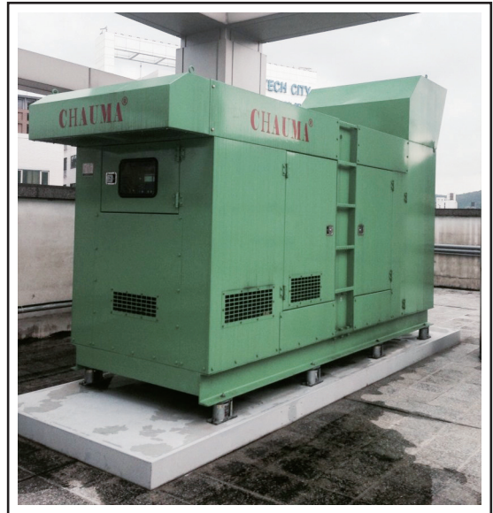
發電機安裝YS-B彈簧式避振器
